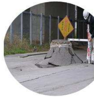
車道中央のマンホール
